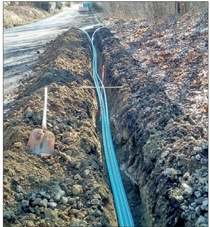
Rohrverbände werden zwischen Colditz und Zschadraß verlegt
