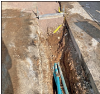
Offener Graben mit Rohrverbund
