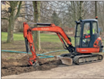
Bagger beim Ausheben des Grabens
