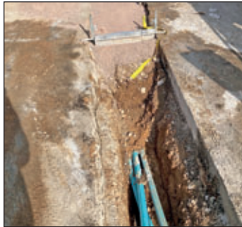
Offener Graben mit Rohrverbund
