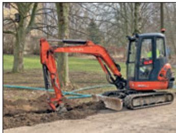
Bagger beim Ausheben des Grabens
